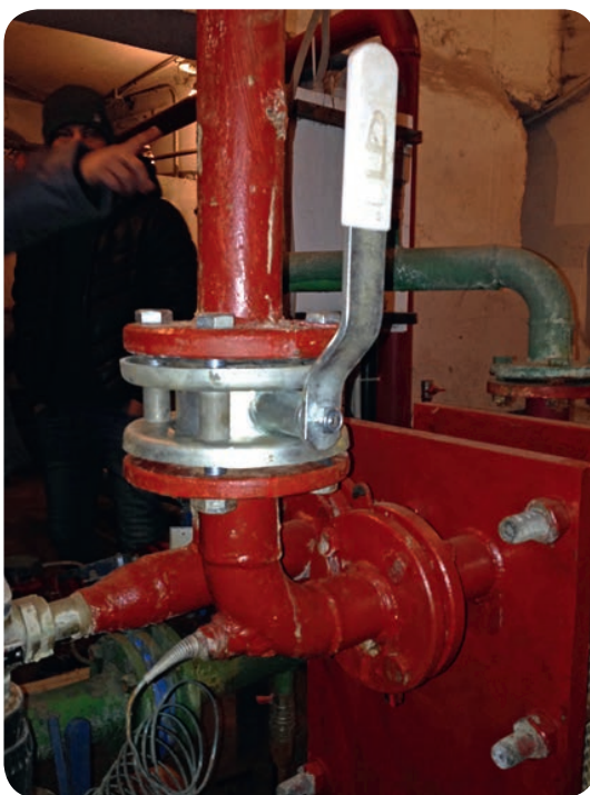
КОНТУР ГВС ПОСЛЕ ПЛАСТИНЧАТОГО ТЕПЛООБМЕННИКА
