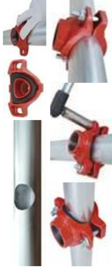
Рис.3. Установка отвода (седелка) под резьбу на трубопровод.
